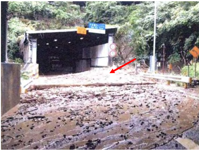
写真-4 土砂流出：福井河川国道
