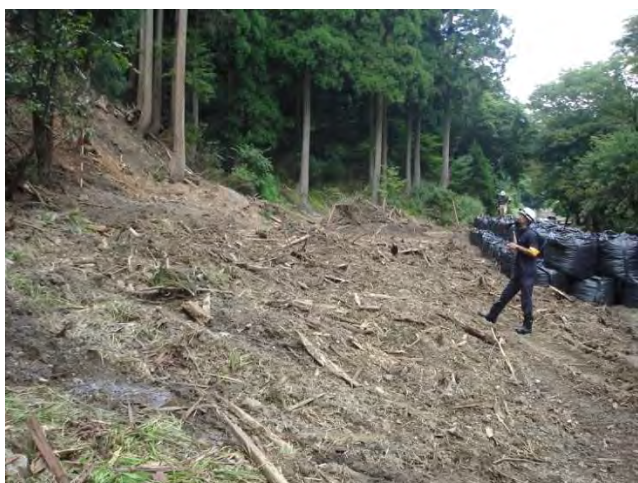
写真-4 道路右側の土石流
