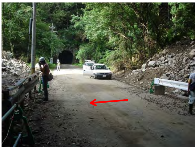
写真-6 道路上の土石流堆積物
