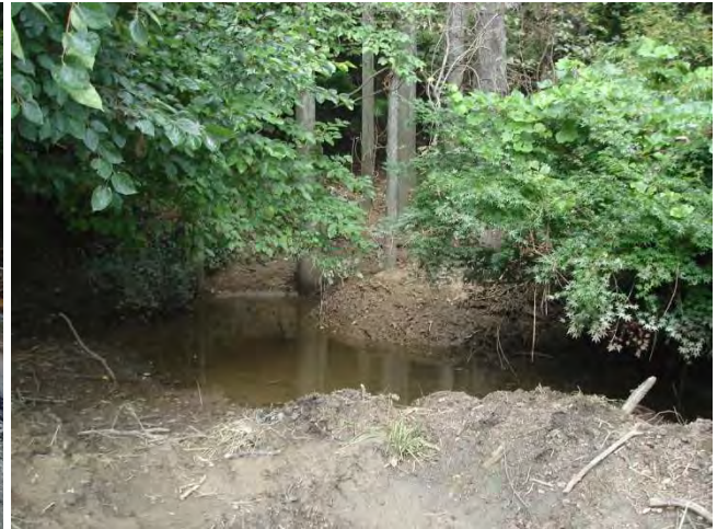
写真-3 道路右側 谷部の湛水 (排水管閉塞?)
