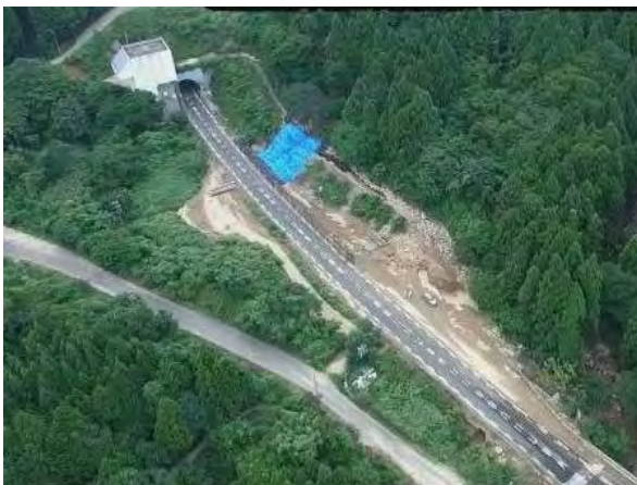
写真-2 上り線 敦賀側坑口付近
