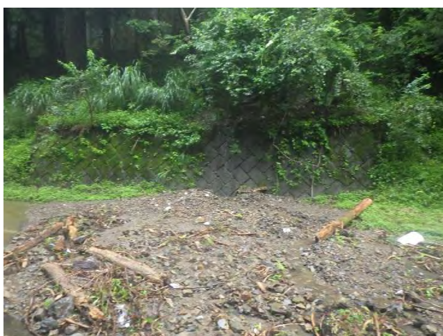
写真-3 沢からの土砂流出
