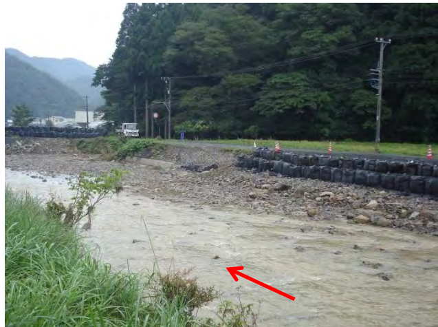
写真-17 橋梁 B から下流部
