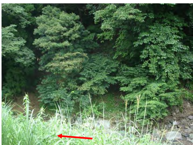
写真-5 右岸での河岸浸食
