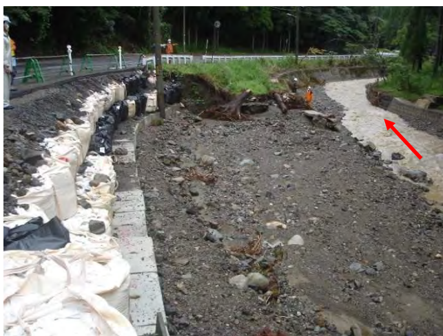
写真-2 護岸損壊 (福井県提供)
