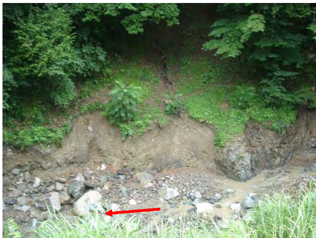
写真-3 右岸での河岸浸食
