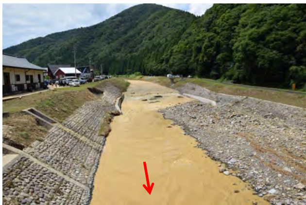
写真-4 災害直後 橋梁 A の上流側
