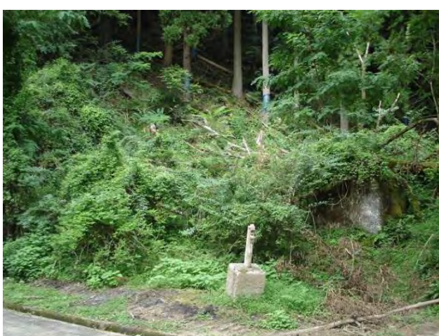
写真-9 道路左側（山側）斜面に土砂流痕なし
