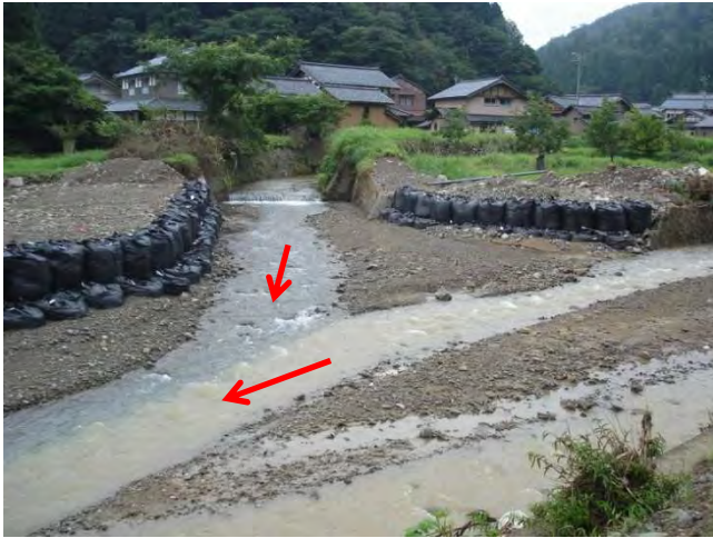
写真-12 右岸側からの支川合流部
