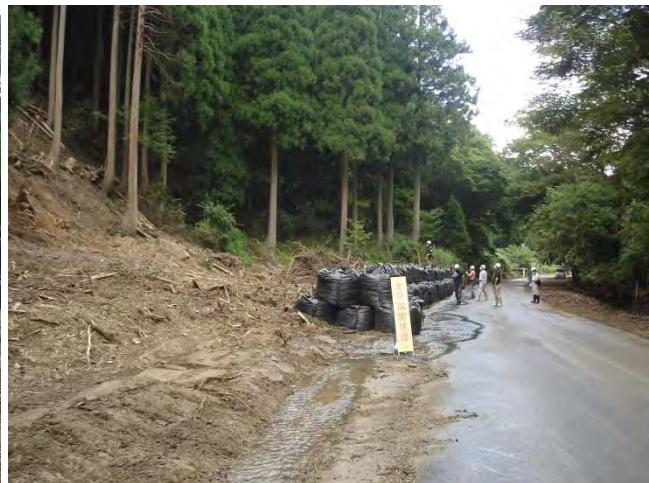
写真-4 道路右側の土石流と道路への流出
