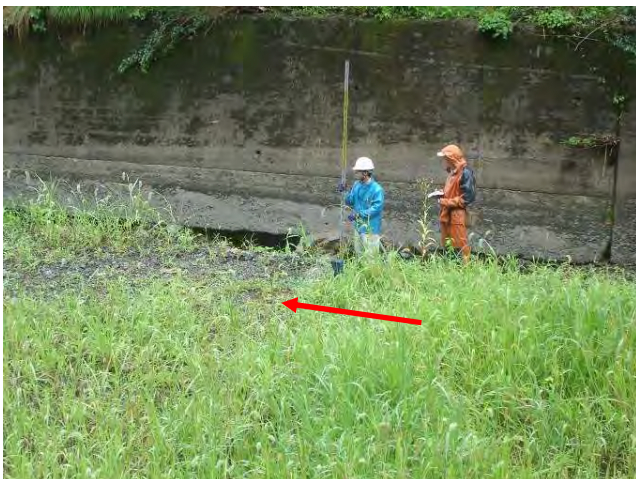
写真-8 既設大型ブロック積み護岸の基礎部洗堀調査
