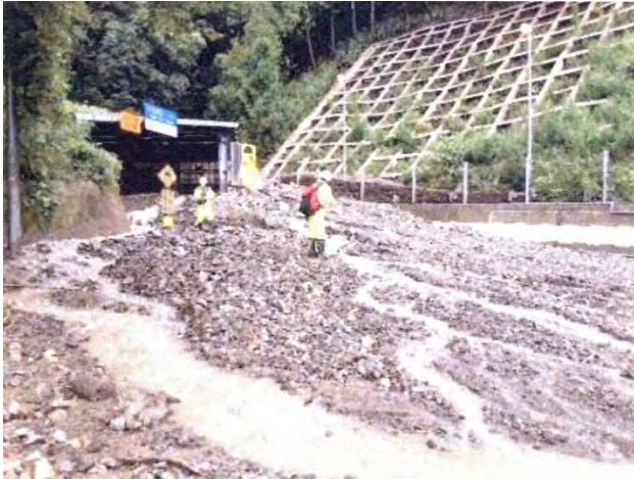
写真-4 土砂流出：福井河川国道
