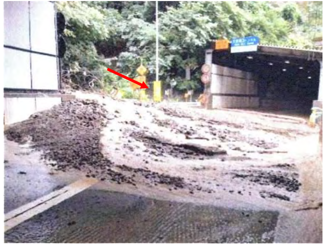
写真-5 土砂流出：福井河川国道
