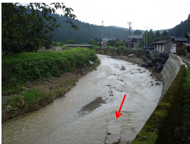
写真-4 大量の土砂堆積箇所の直下流部
