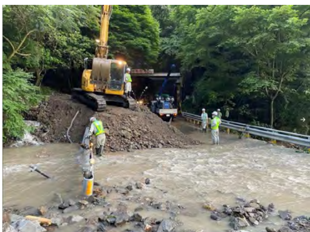
写真-6 土砂撤去作業 福井河川国道 Twitter 8/5
