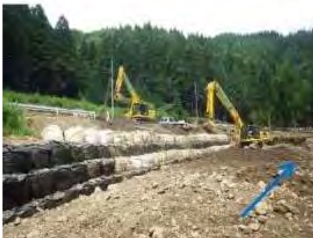
写真-2 護岸損壊 (福井県提供)
