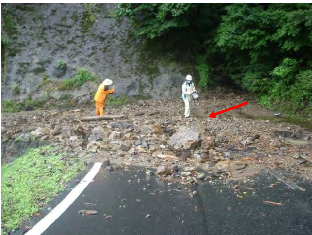
写真-5 沢からの土砂流出（排水管閉塞）
