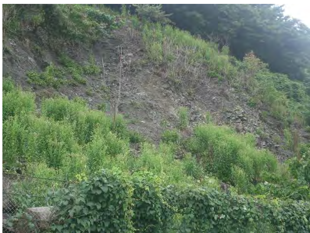
写真-8 表層崩壊
