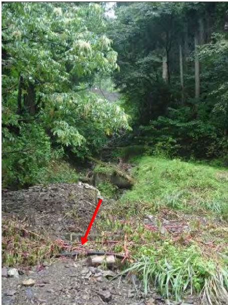
写真-4 右岸沢からの土砂流出
