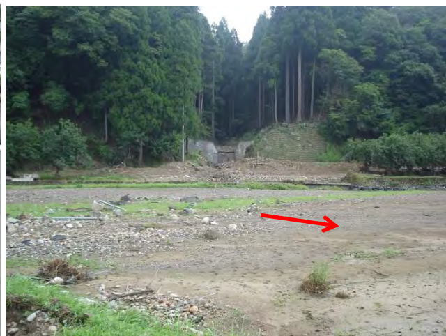
写真-3 越流堆積物 (左岸側)
