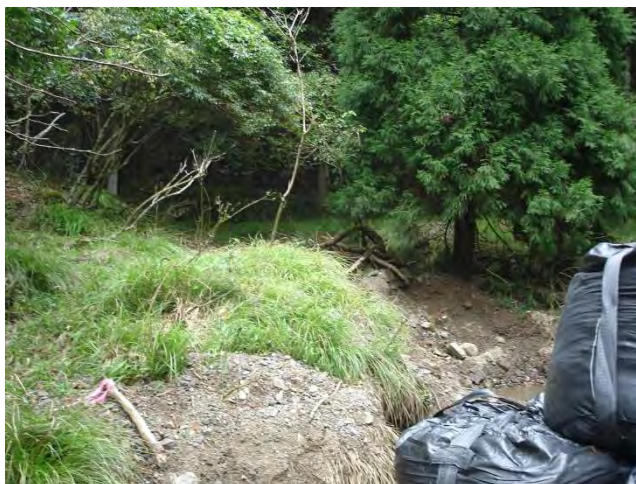
写真-5 路肩崩壊箇所の道路左側の土石流痕
