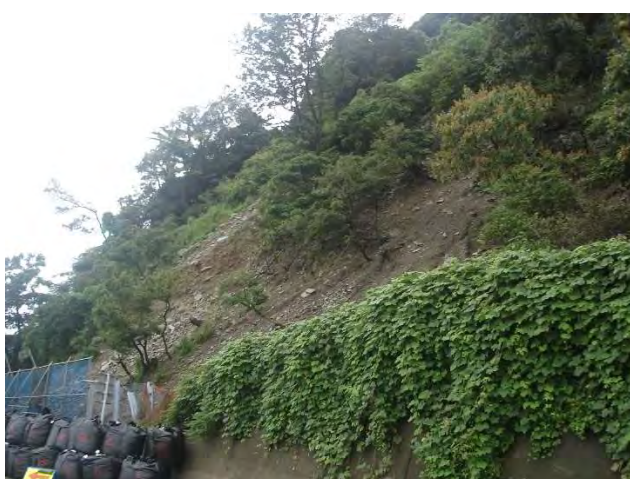
写真-6 斜面崩壊
