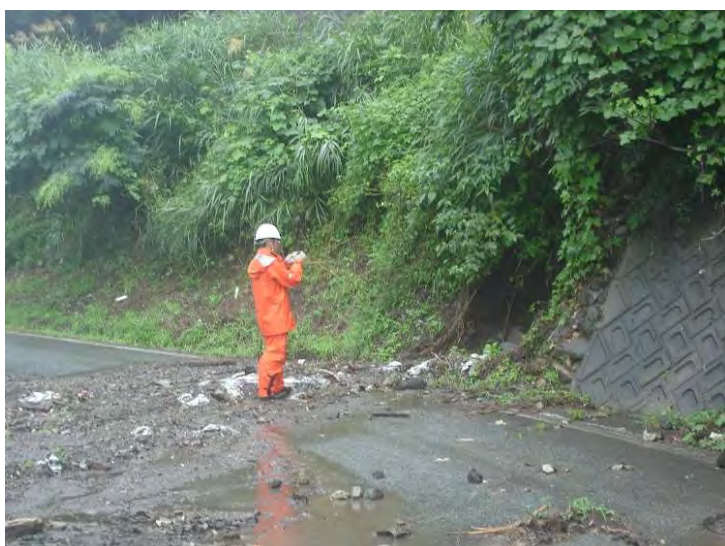
写真-10 沢からの土砂流出
