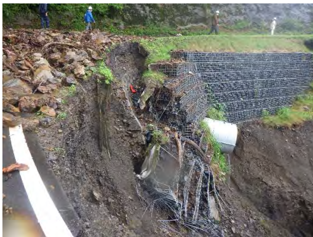
写真-8 崩壊斜面右側上部（カゴ枠工）
