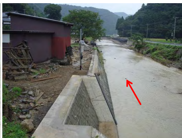
写真-11 橋梁 B から下流部
