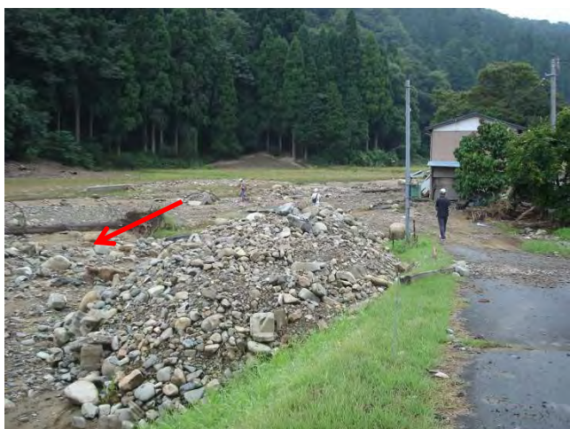
写真-8 土砂堆積箇所
