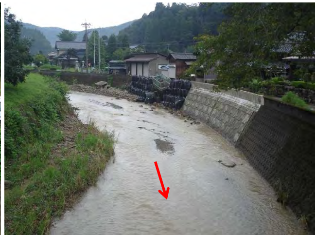
写真-3 土砂堆積箇所の下流部（集落）
