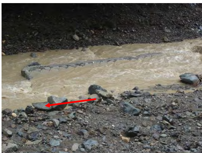
写真 6 流失した護岸
