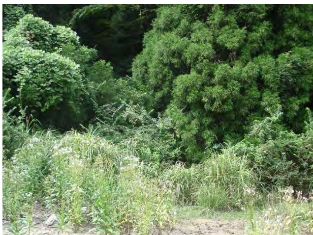
写真-7 道路右側の斜面崩壊部付近の沢
