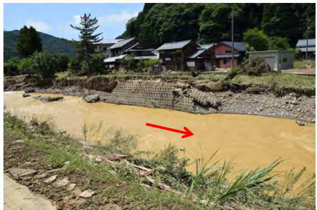
写真 5 -災害直後の橋梁 B 上流部
