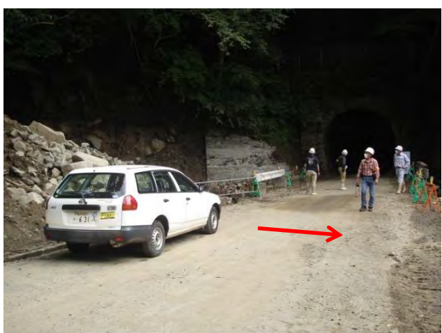
写真-8 道路上の土石流堆積物
