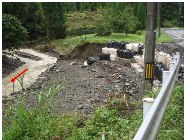
写真-5 上部が（孫谷-板取）6 護岸の流失（写真左中段） 手前が（孫谷-板取）5
