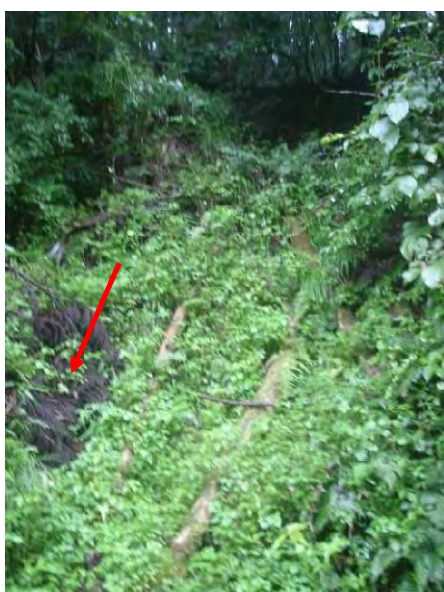
写真-3 沢部の状況
