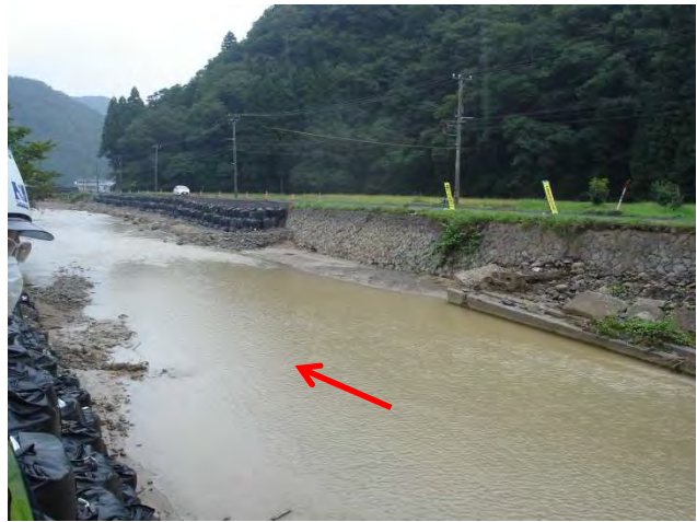
写真-13 橋梁 B から下流部
