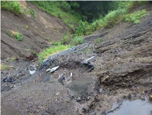
写真-13 崩壊斜面の底部
