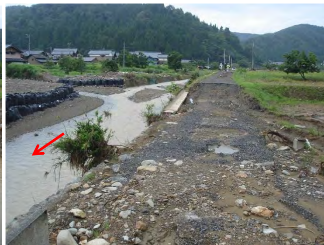
写真-11 右岸側からの支川合流部
