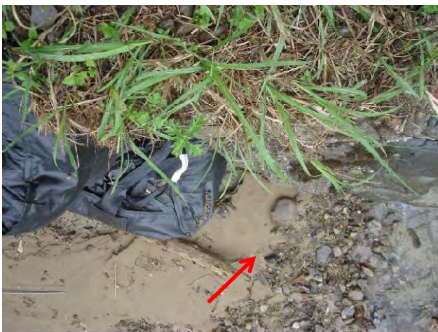
写真-14 橋梁 B から下流部
