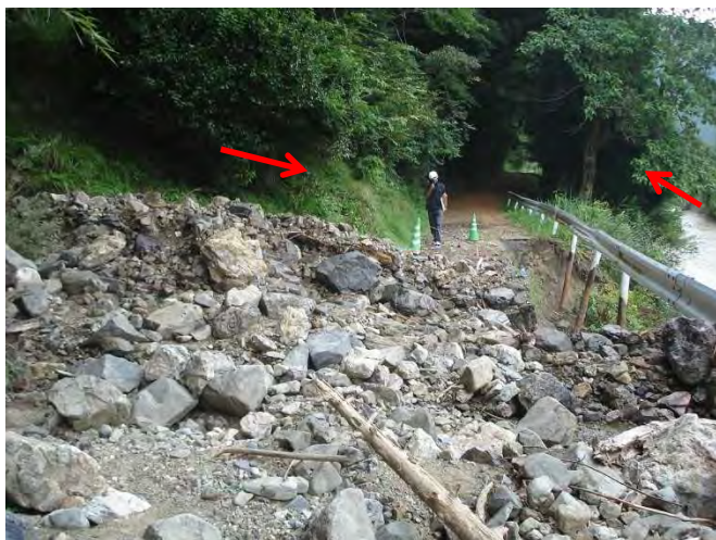
写真-4 土石流堆積物
