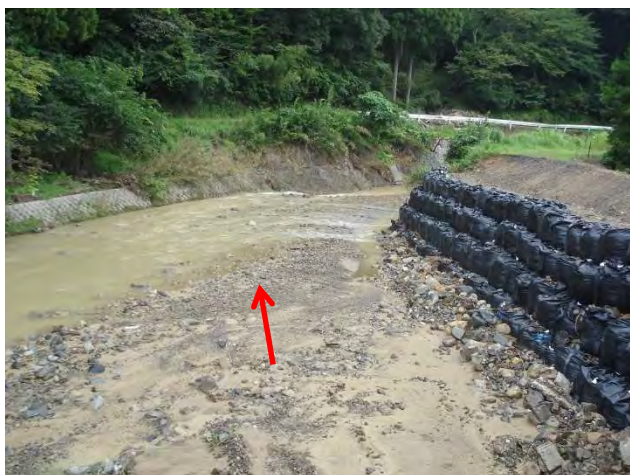
写真-9 損壊橋梁の下流部
