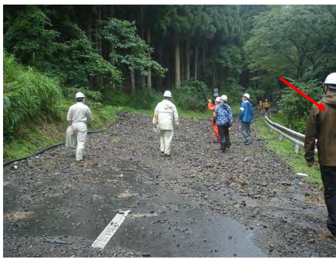
写真-10 写真-9による堆積土砂
