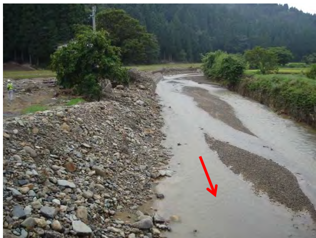
写真-7 土砂堆積箇所
