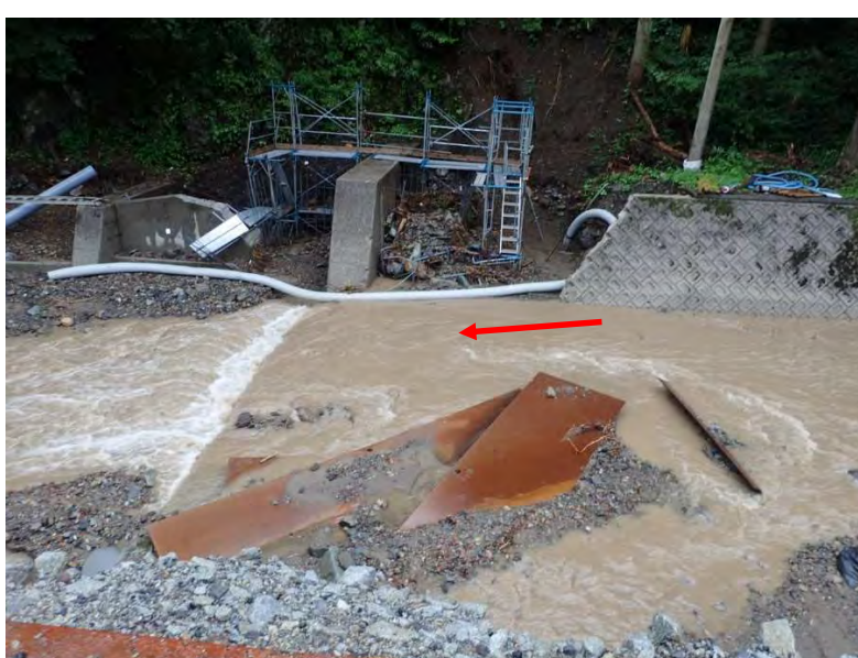
写真-5 施工中の堰、護岸など（災害直後）
