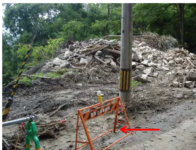
写真-7 道路上の土石流堆積物
