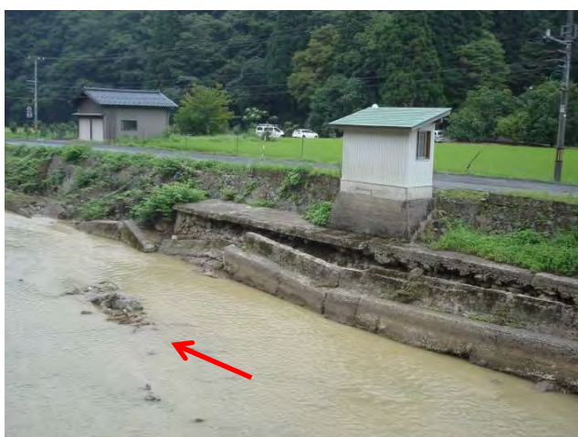
写真-10 橋梁 B から下流部
