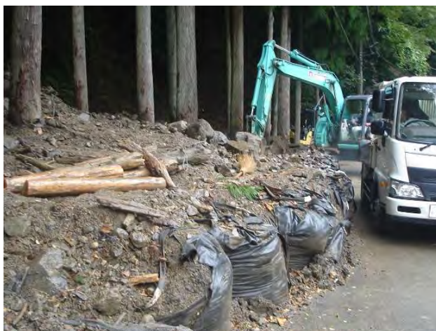
写真-6 流出土砂の撤去作業中
