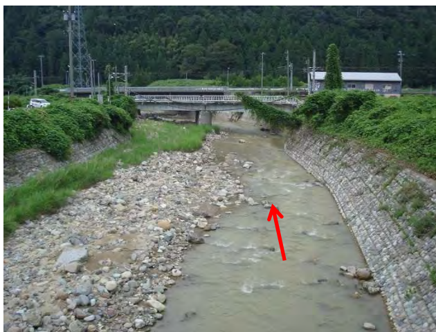
写真-6 橋梁 A の下流側
