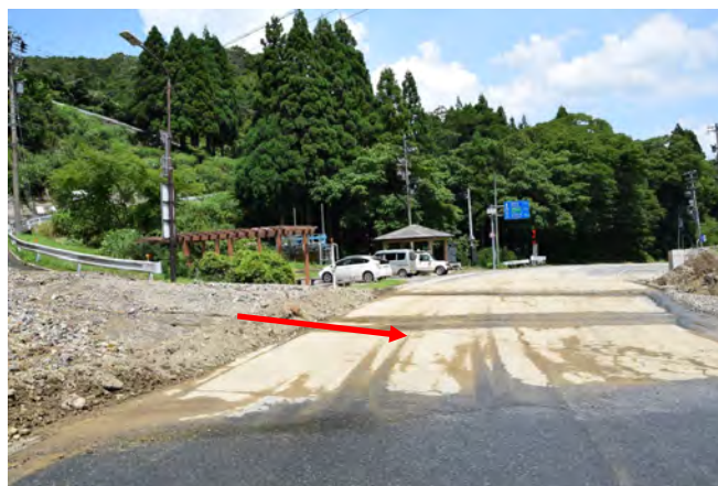
写真-4 土砂流出（災害直後）
