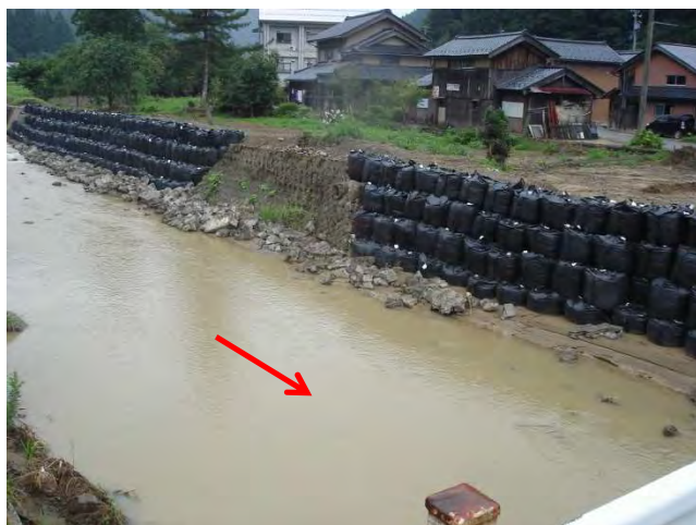
写真-7 橋梁 B から上流部
