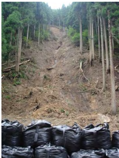
写真-2 道路右側の土石流痕と源頭部の斜面崩壊
