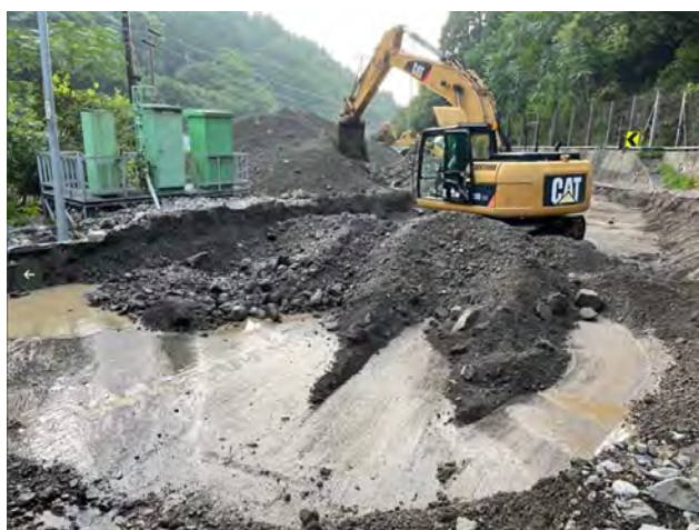
写真-7 土砂撤去作業 福井河川国道 Twitter 8/5
