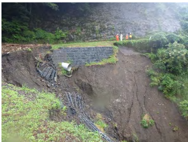
写真-7 崩壊斜面右側上部（カゴ枠工）
