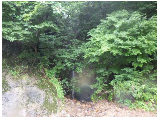
写真-4 沢からの土砂流出
