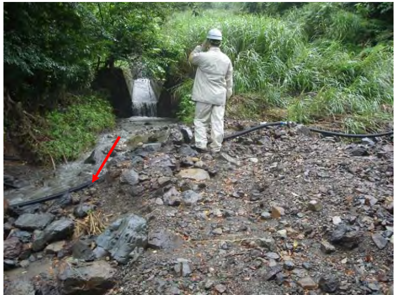
写真-5 右岸水路からの土砂流出
