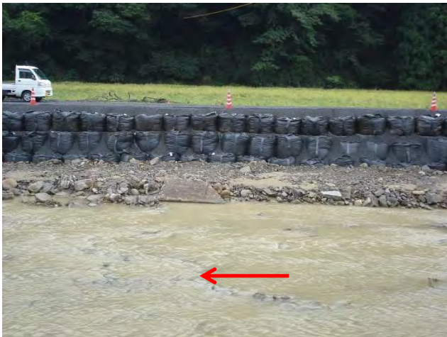
写真-16 橋梁 B から下流部
