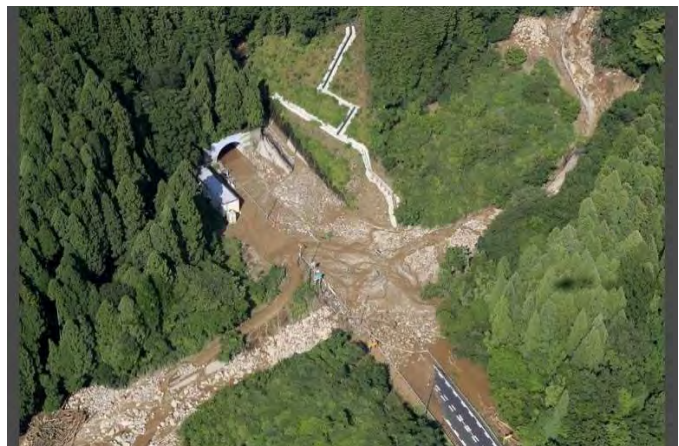
写真-3 下り線 敦賀側坑口付近
