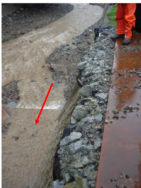
写真-4 施工中の堰、護岸など
