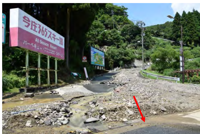
写真-2 土砂流出（災害直後）
