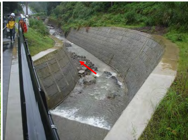
写真-9 既設大型ブロック積み護岸（損傷なし）
