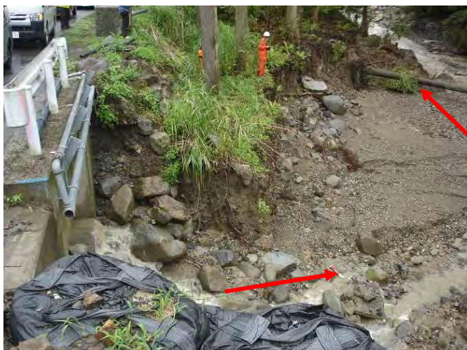
写真-6 上流側 左岸側からの排水施設
