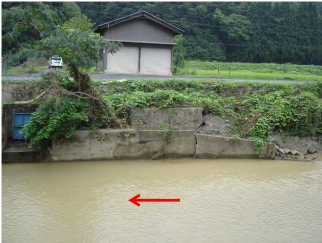
写真-12 橋梁 B から下流部
