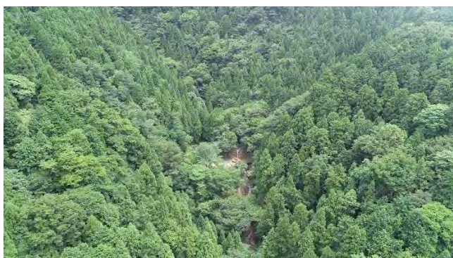
写真-2 被災箇所全景（福井県提供）
