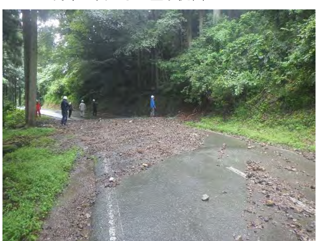
写真-5 沢からの土砂流出
