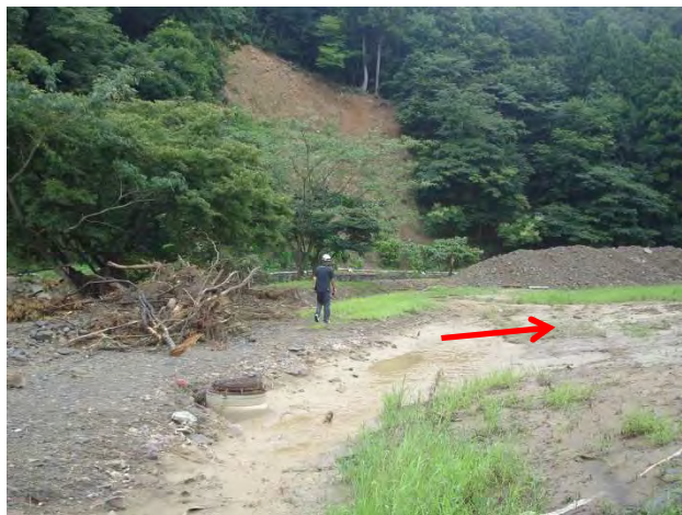
写真-5 土砂集積箇所下流部の過去の崩壊斜面
