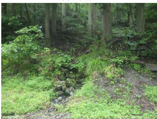
写真-4 沢からの土砂流出
