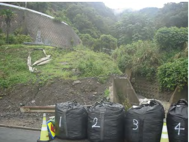
写真-4 排水路（上部に道路）
