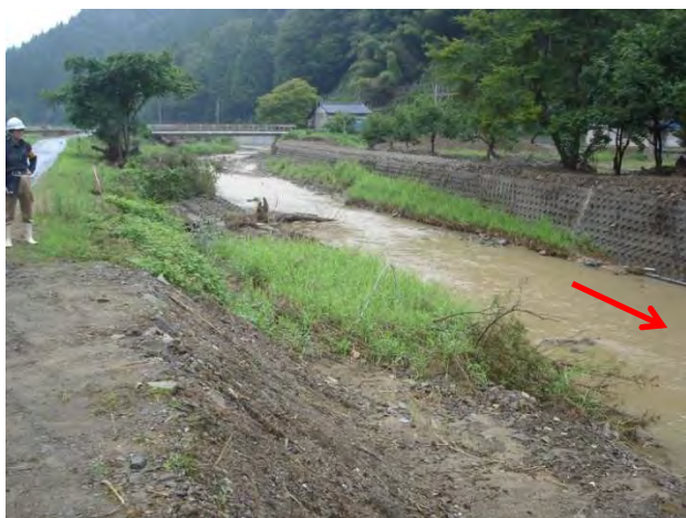
写真-2 土砂集積箇所の下流部
