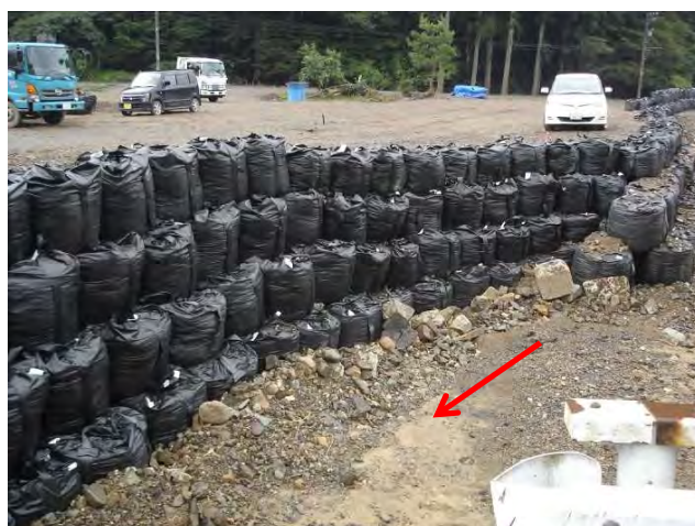
写真-6 損壊橋梁の直上流部
