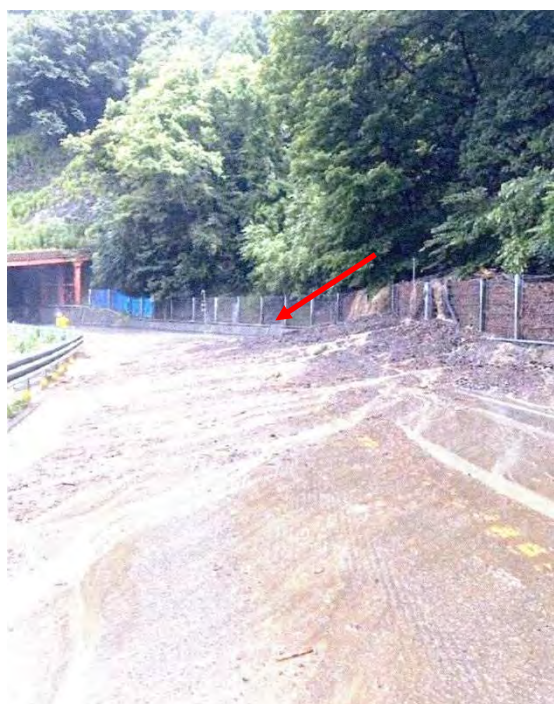
写真-2 土砂流出：福井河川国道
