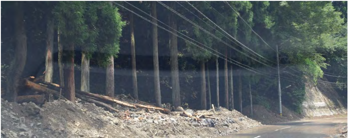
写真-2 土砂流出 (災害直後)
