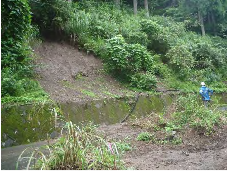
写真-5 付近の表層崩壊（擁壁損傷なし）
