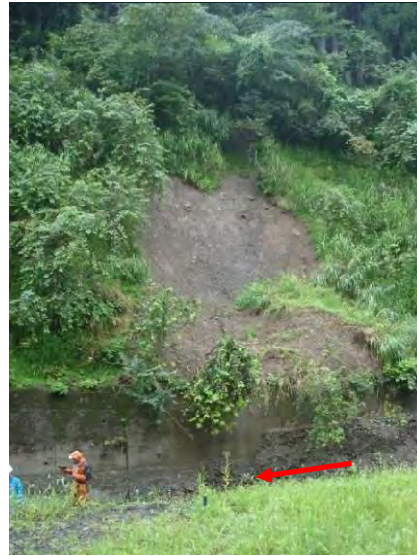
写真-5 付近での表層崩壊
