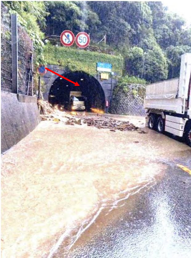
写真-2 土砂流出：福井河川国道
