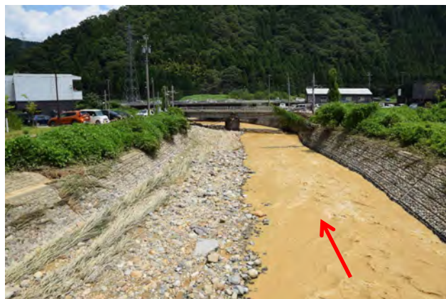
写真-5 災害直後 橋梁 A の下流側
