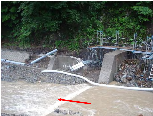
写真-3 施工中の堰、護岸など
