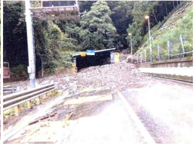
写真-5 土砂流出：福井河川国道
