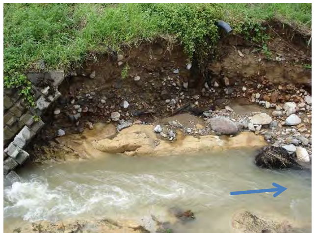
写真-8 護岸基礎の岩盤
