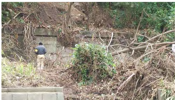
写真-10 道路際擁壁上部の擁壁
