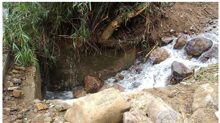
写真-4 道路横断暗渠管の上流部
