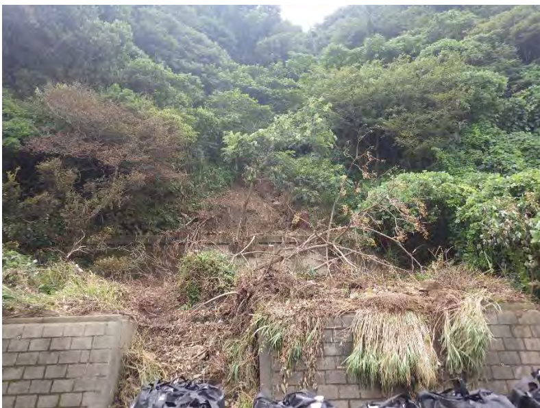
写真-7 道路から見た全景
