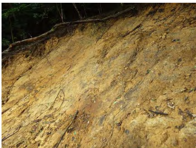
写真-7 崩壊面の露岩
