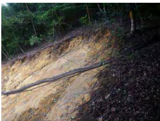
写真-9 上部から見た崩壊面
