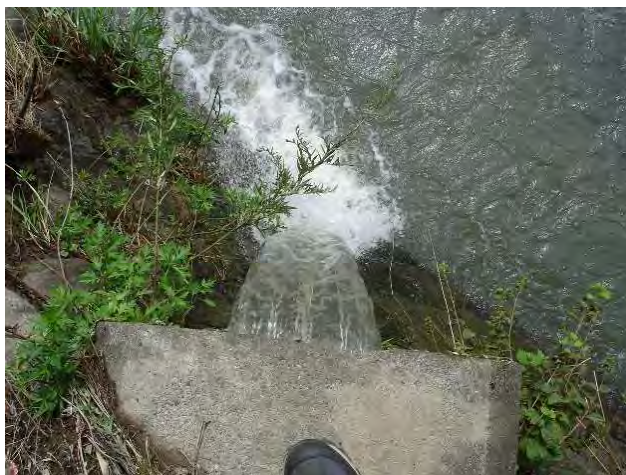
写真-5 上流部での流入
