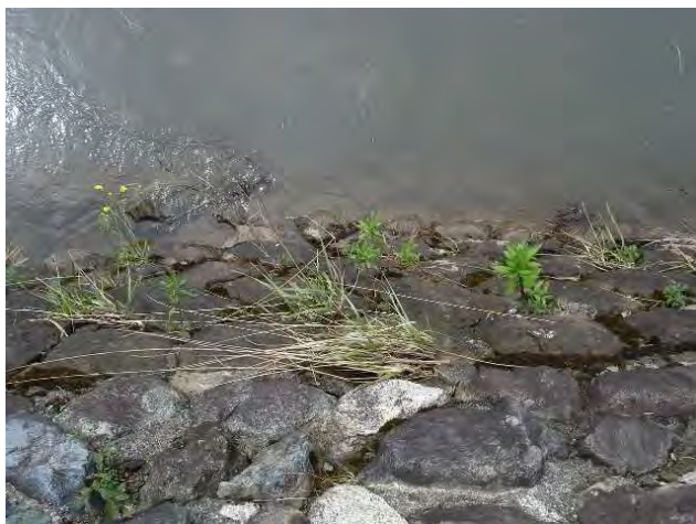
写真-4 石積みと基礎の状況
