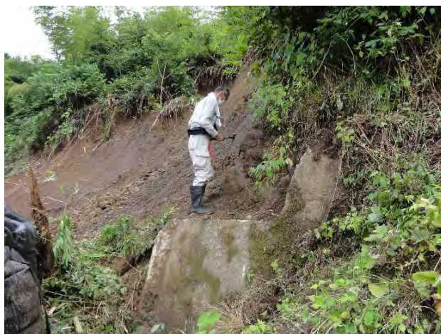
写真-5 全景（右側から）
