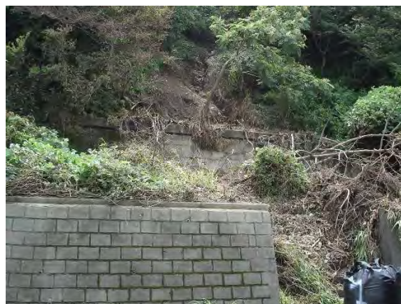
写真-12 道路際擁壁の階段工
