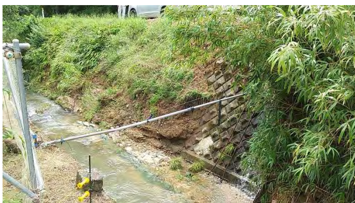
写真-9 右岸側全景
