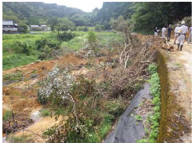
写真-4 崩壊土砂の流動
