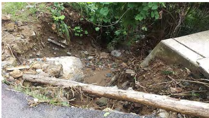
写真-5 道路横断暗渠管（下流側）
