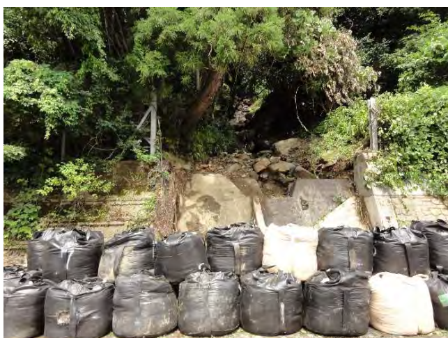
写真-7 既設の谷止め工
