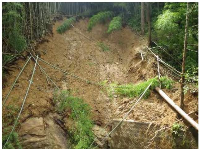
写真-8 崩壊斜面（左岸）下部
