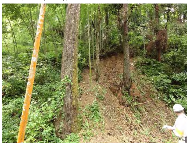
写真-14 隣接崩壊斜面
