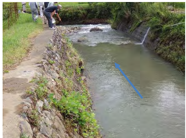
写真-3 水の流れ (上流側から)
