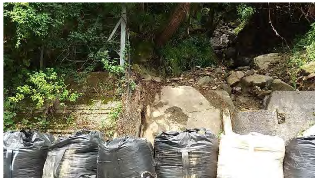
写真-6 既設の谷止め工
