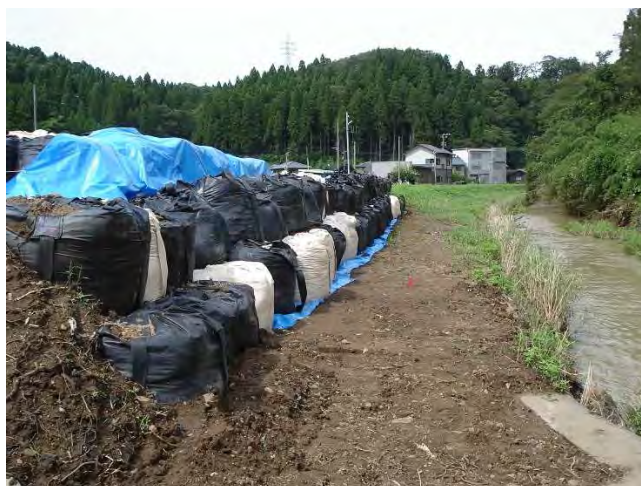
写真-11 堤外側の土のう (2段)
