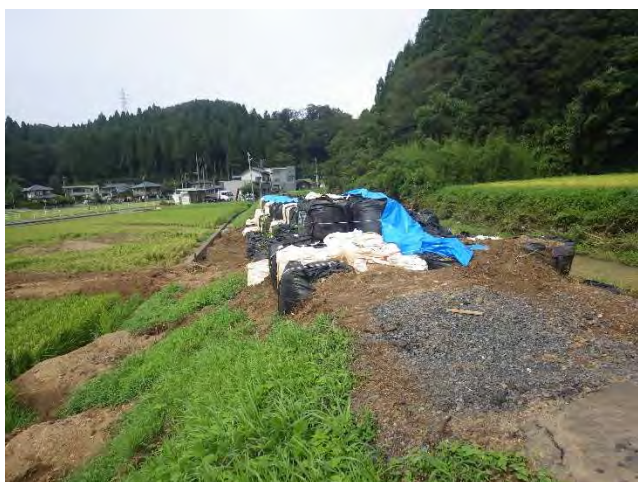
写真-12 堤内側の土のう (3段)
