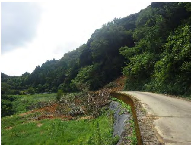
写真-3 崩壊土砂の流動
