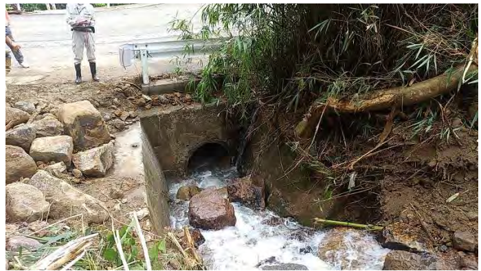
写真-2 道路横断暗渠管 (上流側)
