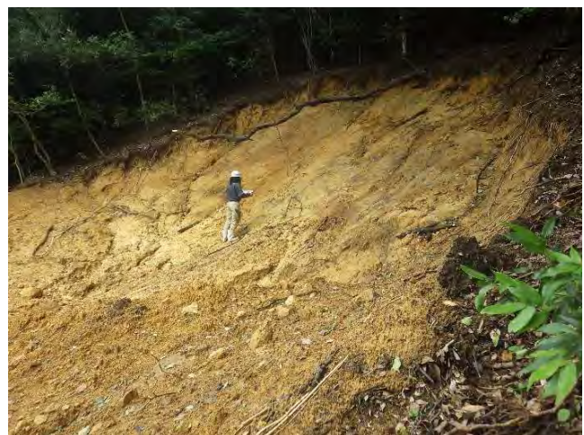
写真-6 崩壊面の露岩
