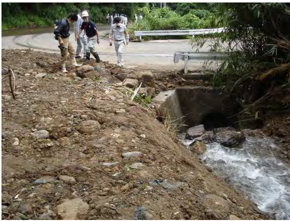
写真-1 道路横断暗渠管 (上流側)
