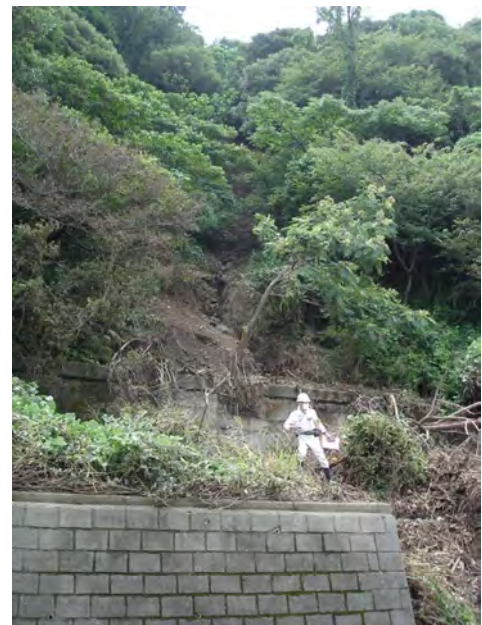
写真-8 道路から見た全景
