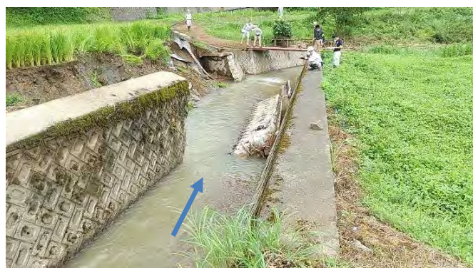
写真-8 上流側から
