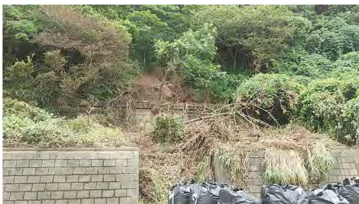
写真-11 道路際擁壁の階段工
