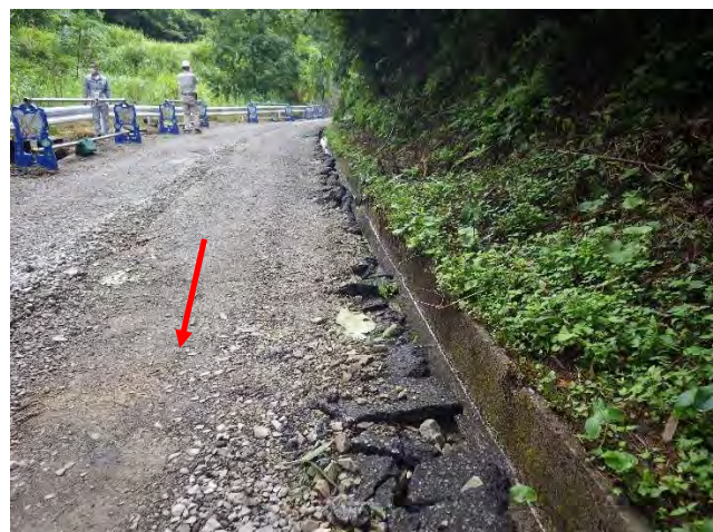
写真-4 山側側溝付近の舗装の掘り上がり
