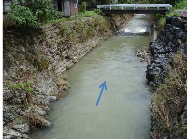
写真-2 左岸の状況
