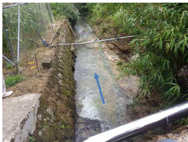
写真-4 上流側から
