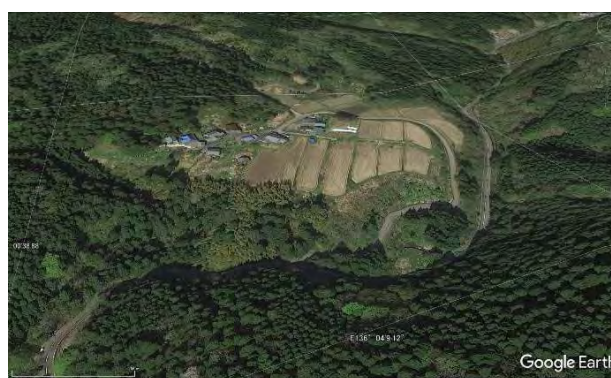
写真-2 崩壊個所の周辺の地形
