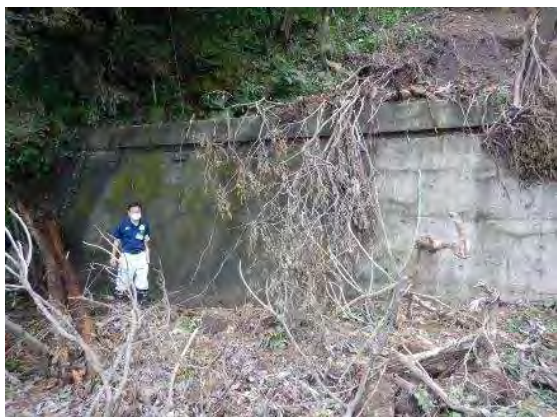
写真-9 道路際擁壁上部の擁壁
