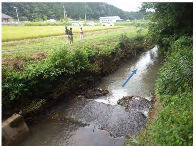
写真-4 上流部落差工
