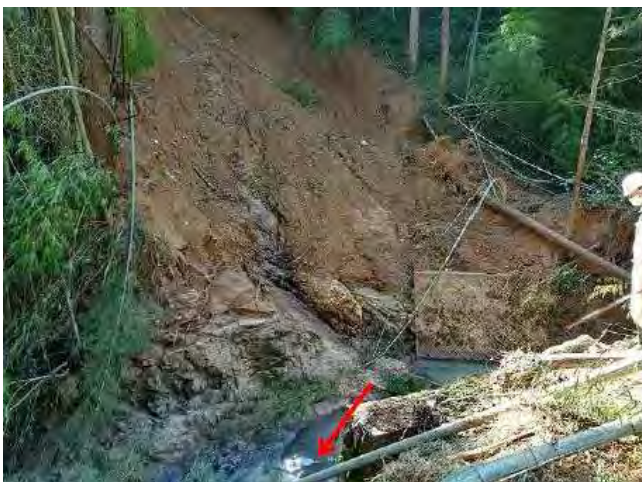
写真-7 崩壊斜面（左岸）下部
