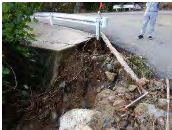
写真-6 道路横断暗渠管（下流側）
