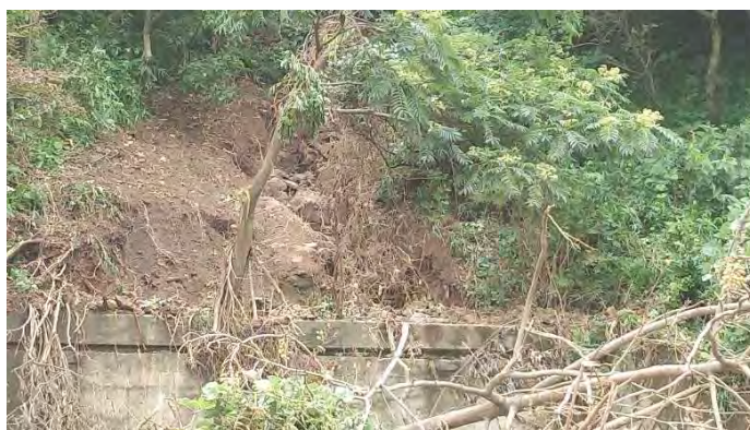
写真-14 道路際擁壁の上部
