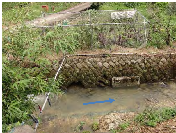
写真-2 左岸側全景
