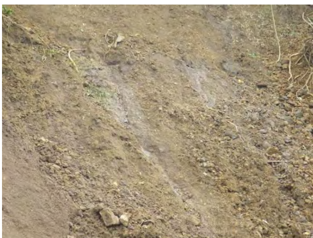
写真-7 湧水状況
