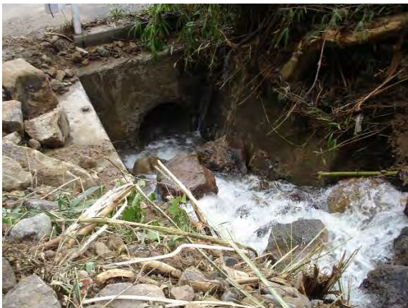
写真-3 道路横断暗渠管 (上流側)
