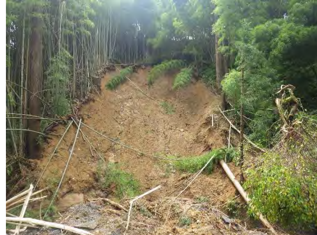
写真-4 崩壊斜面（左岸）上部
