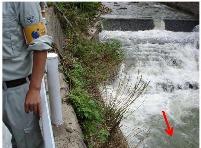
写真-12 落差工（下流側から）
