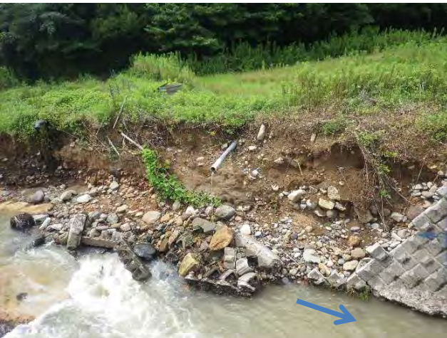
写真-7 護岸内の排水管
