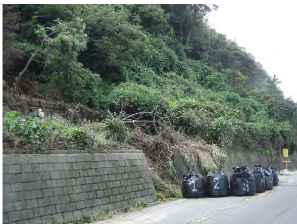
写真-13 道路際擁壁の階段工
