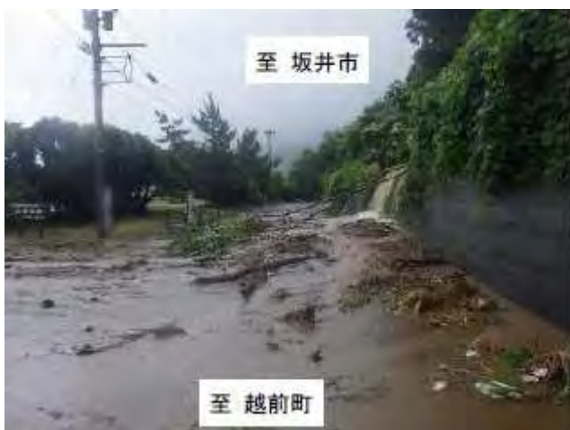
写真-1 土砂流出直後
