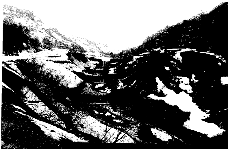
万内川の砂防堰堤群
